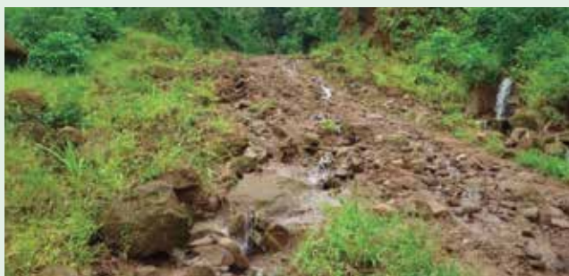
Imagen 2. Camino hacia el Recinto La Dibujada, nótese la emanación de agua de las colinas.
