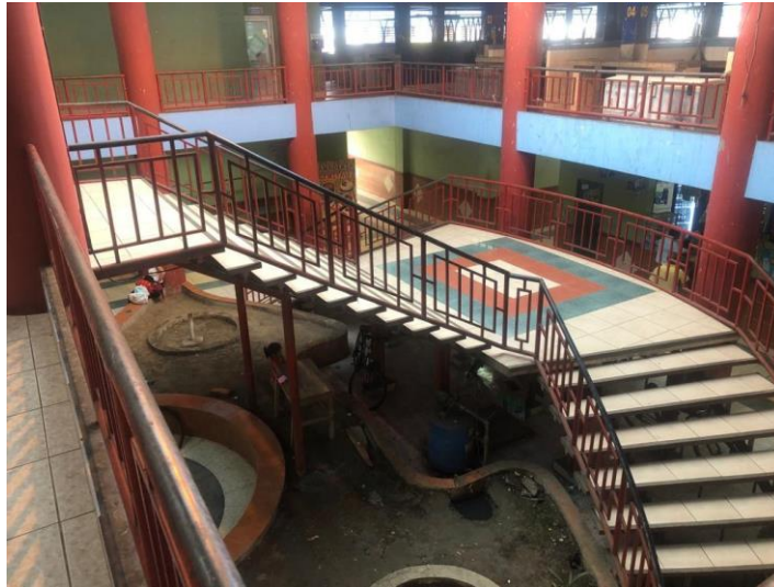
Figura 2 Acceso a la segunda planta del mercado de abasto del cantón Santa Ana
