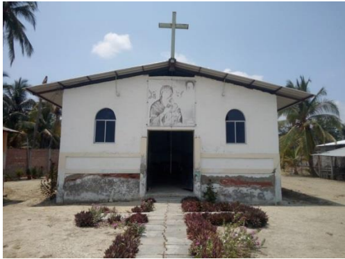
FACHADA ( Tomada por Iter Muñoz)
