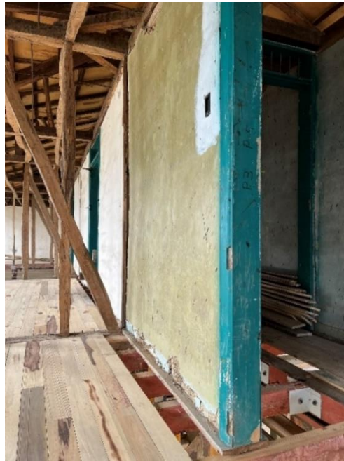
Figura Nro. 8: Enquinchado tradicional, Paredes divisoras. Fotografía: Stalin Iza (2022)
