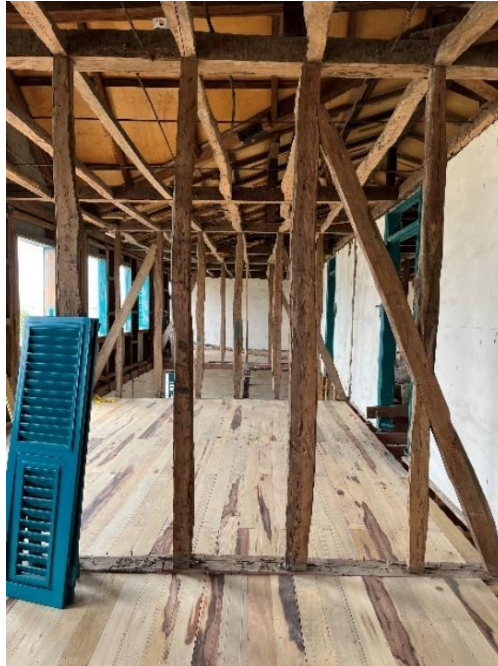
Figura Nro. 6: Caja y Espiga, Estructura de las paredes divisorias Fotografía: Stalin Iza (2022)
