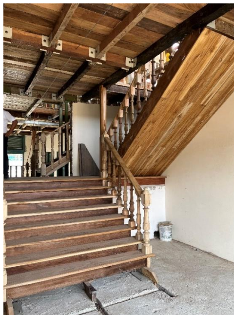
Figura Nro. 5: Balastrado de madera, Gradas de acceso a las plantas superiores Fotografía: Stalin Iza (2022)
