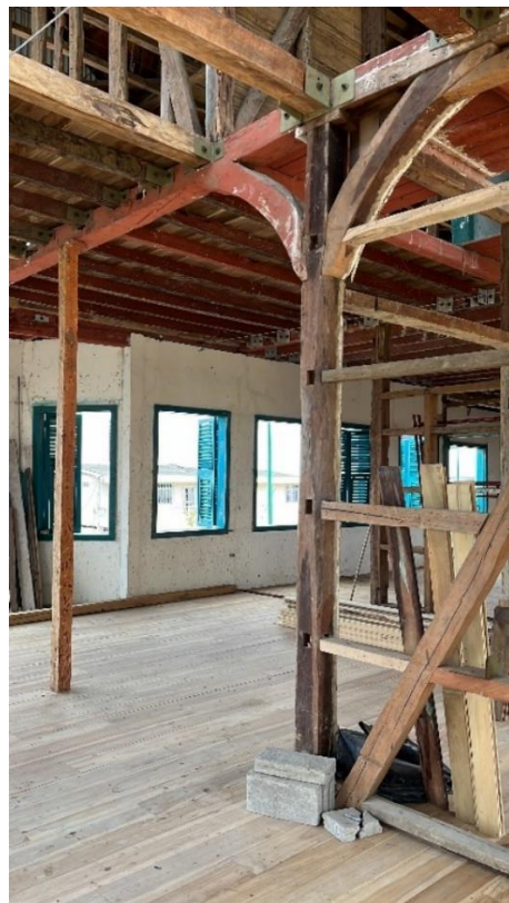
Figura Nro. 7: Uniones tradicionales, columnas de madera. Fotografía: Stalin Iza (2022)
