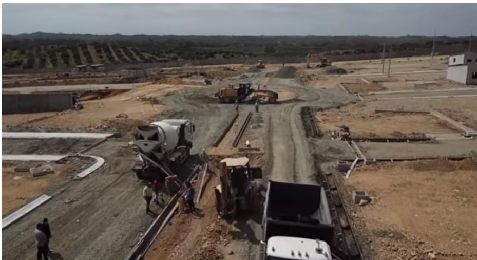
Ilustración 10 Espacio en construcción de conjunto habitacional bella vita Fuente: Elaboración propia
