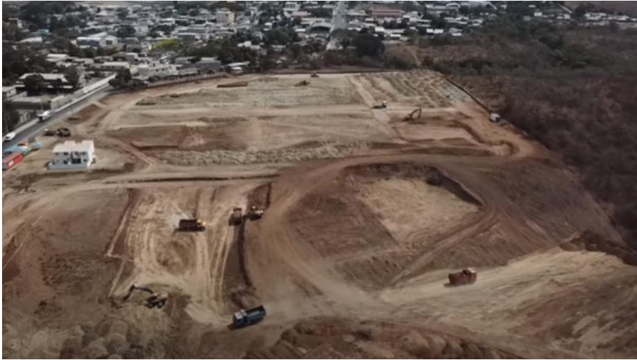
Ilustración 11 Espacio en construcción de conjunto habitacional bella vita Fuente: Elaboración propia
