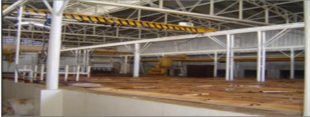
Figura 10 Vista de una planta de hielo industrial
