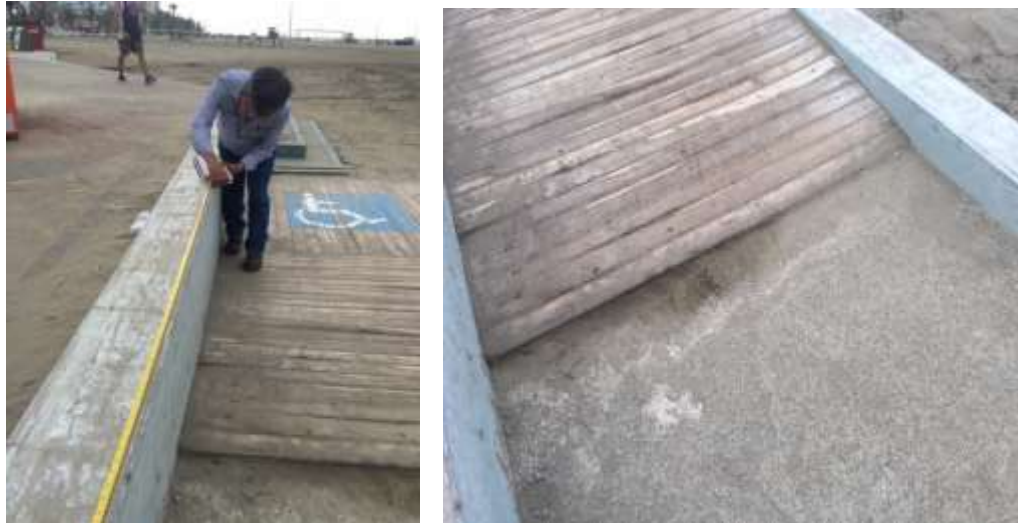
Figura Nro. 39 Levantamiento de datos rampa mixta hormigón y madera en la parte inferior de ingreso a la caminera de madera instalada en la playa “El Murciélago”.
