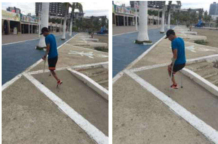
Figura Nro. 37 Usuario con discapacidad física en su tránsito por la rampa de hormigón de acceso del malecón escénico en el área de restaurantes con acceso a la playa “El Murciélago”.
