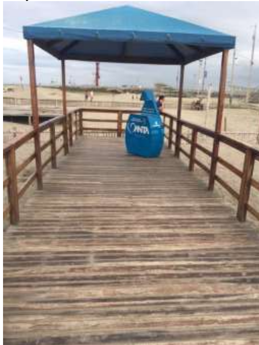
Figura Nro. 42 Rampas laterales con pasamanos y carpa en la caminera de madera instalada en la playa “El Murciélago”.
