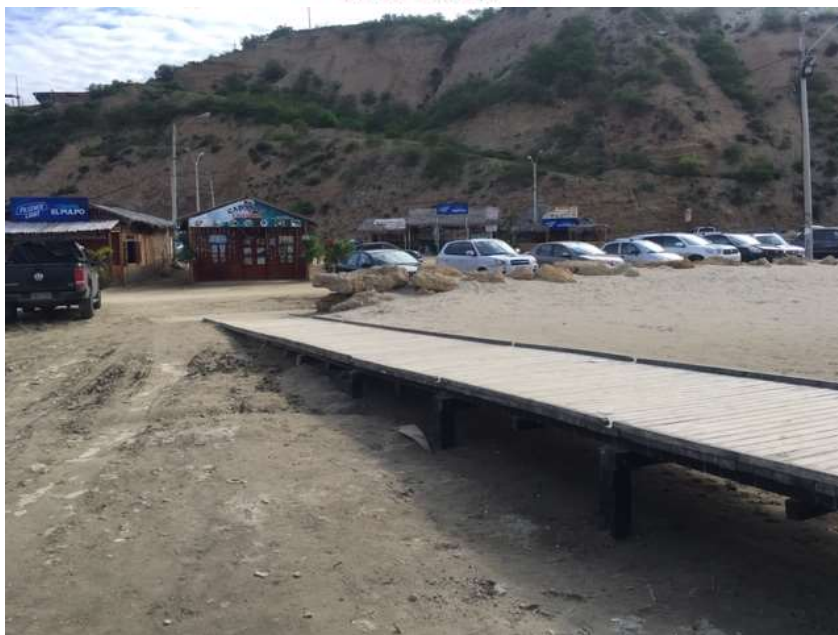
Figura Nro. 29 Estacionamiento y acceso rampa de ingreso principal caminera de madera playa “San Mateo”.
