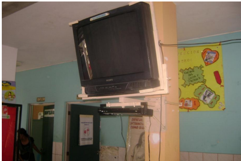
DVD instalado en el televisor de la sala de espera.
